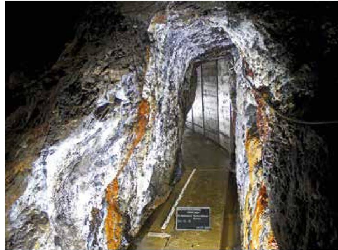
Abb. 5: Nur auf 5 m erhaltener, älterer Streckenquerschnitt des Rathstiefsten Stollens. (© Foto: G. Drechsler/NLD)
