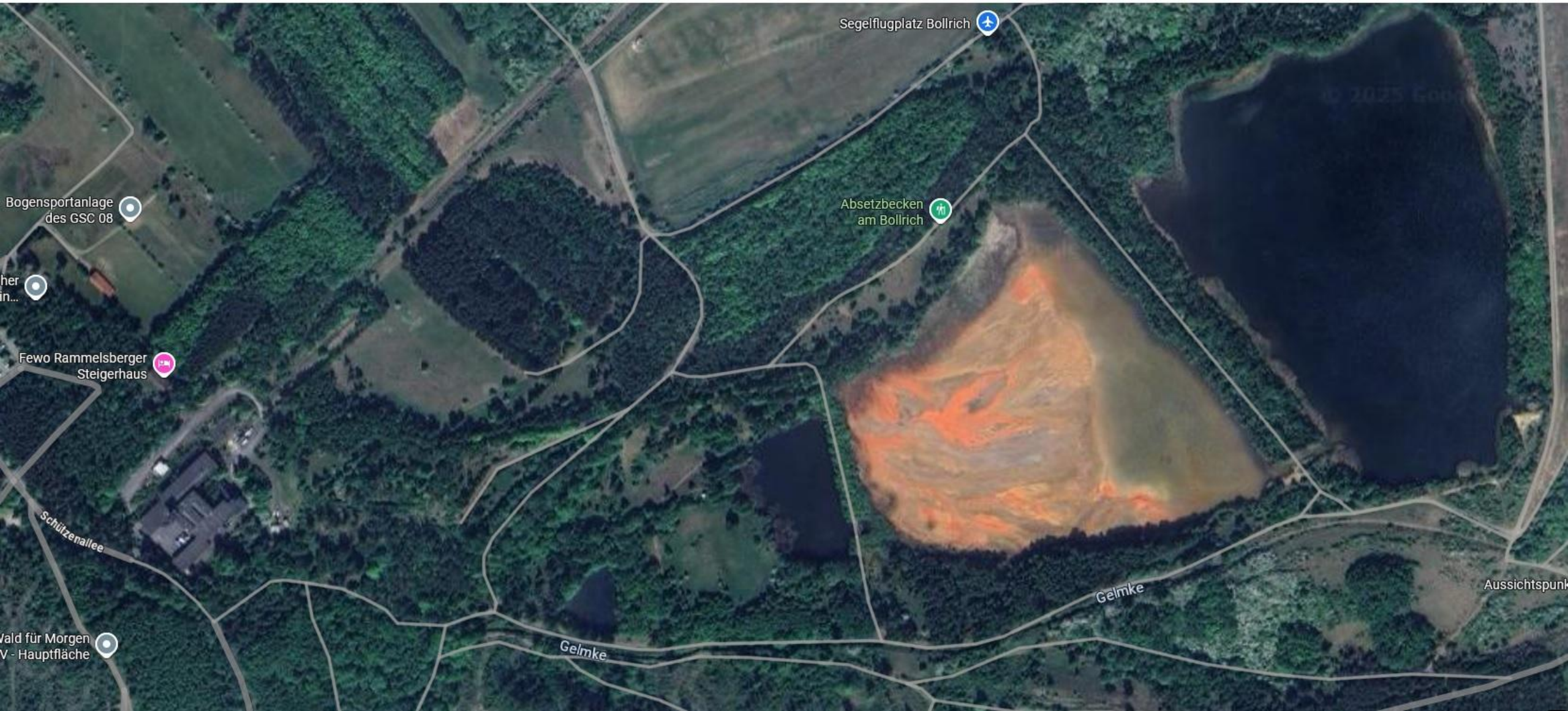
Die Bergeteiche am Bollrich, Absatzbecken für die neutralisierten Grubenwässer vom Rammelsberg
