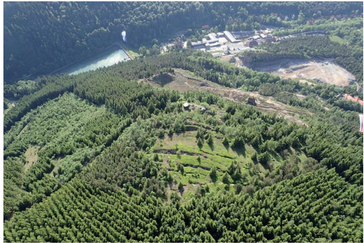
Bergspalten am Rammelsberg infolge der Grubenzusammenbrüche.
