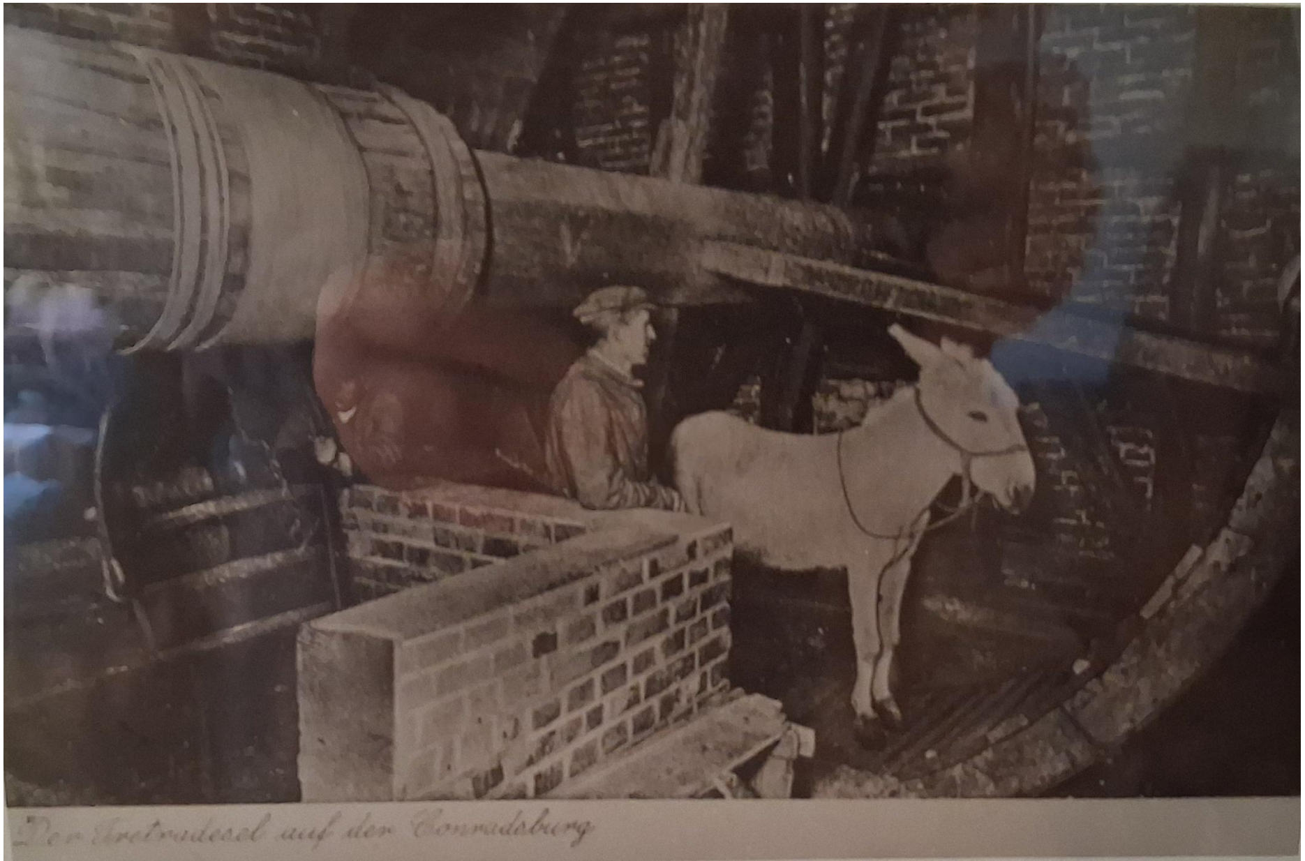
Tretrad auf der Conradsburg (Sachsen-Anhalt). Erstaussattung im Feuergezäher Gewölbe?
