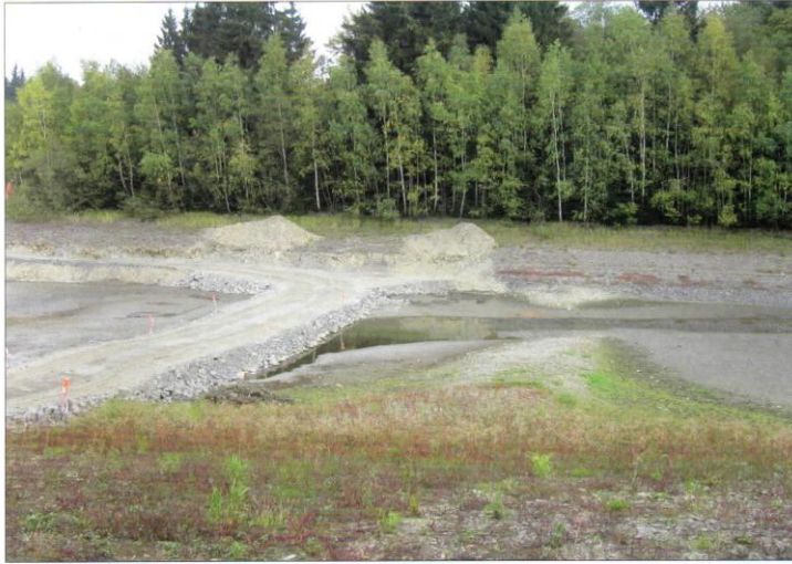
Abb. 3: Durch den Bau einer Behelfsstraße im Zuge der Sanierungsarbeiten im Bereich der Pfaunteiche und des Werks Tanne wurde der historische Teichdamm tangiert, aber gemäß Auflagen der Denkmalbehörden wieder in den Ursprungszustand zurückversetzt; Foto Frank Jacobs 27.9.2011
